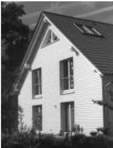
**MOCO** Vollholzprofile machen das Energiesparen perfekt. Bekleidungen mit Vollholzprofilen tragen zur Wärmedämmung bei und sind zudem sehr dekorativ. Hinter Wand-, Decken- oder Fassadenbekleidungen sowie unter einem Dielenboden kann sehr einfach Dämmstoff eingebracht werden.
